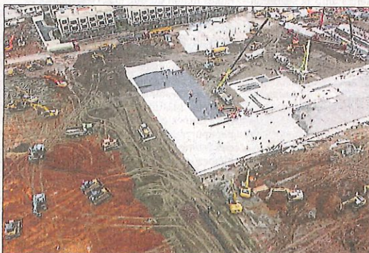
Obres en un dels nous hospitals que s'estan construint
